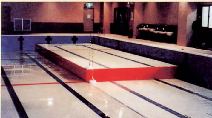
▲プールの床面を上昇させた状態
